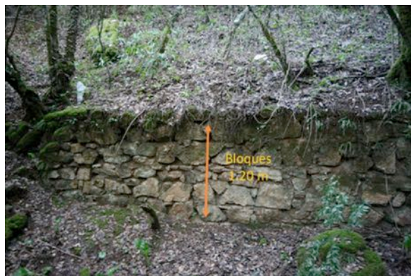
Figura 8. Muro SE, bloques de litologías cámbricas y finalización de la ladera.
